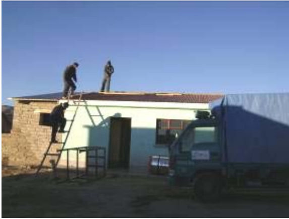
Foto 6. Verificación de puntos de apoyo de las estructuras del sistema termosolar.
