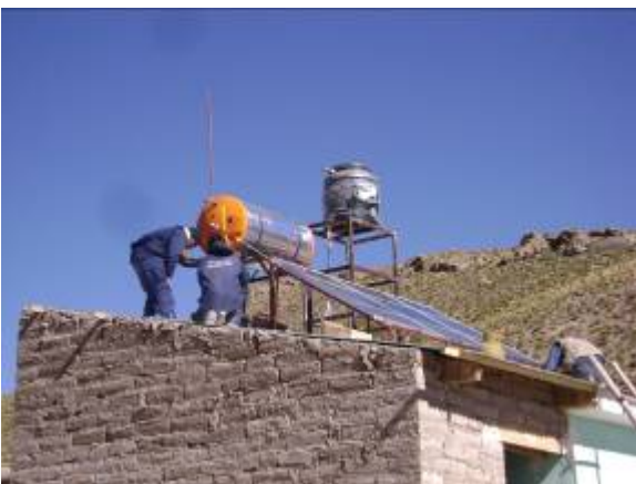
Foto 9. Realización de uniones, acoples y empalmes correspondientes al sistema termosolar.
