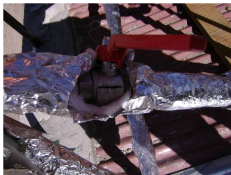
Foto 17. Deterioros modificados por los técnicos instaladores.
