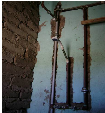
Foto 16. Instalación de la válvula termostática.
