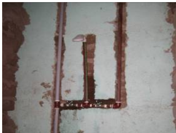
Foto 15. Paredes de las duchas sin revoque.
