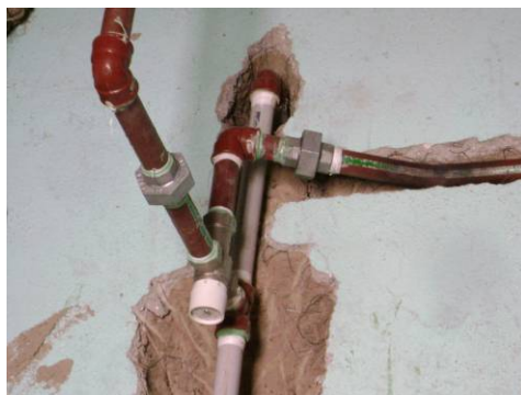
Foto 16. Instalación de la válvula termostática.
