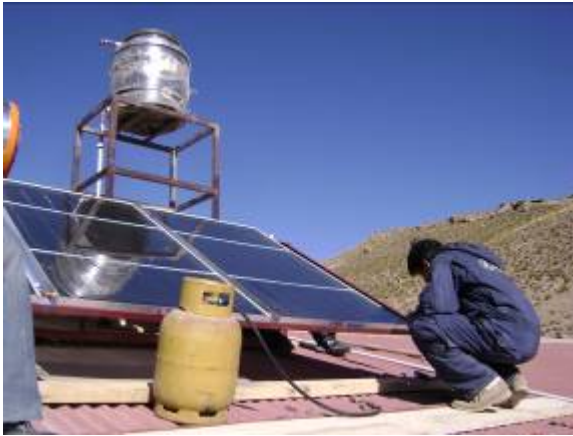
Foto 12. Soldadura de uniones de los colectores y el recubrimiento de las cañerías con material anticongelante.
