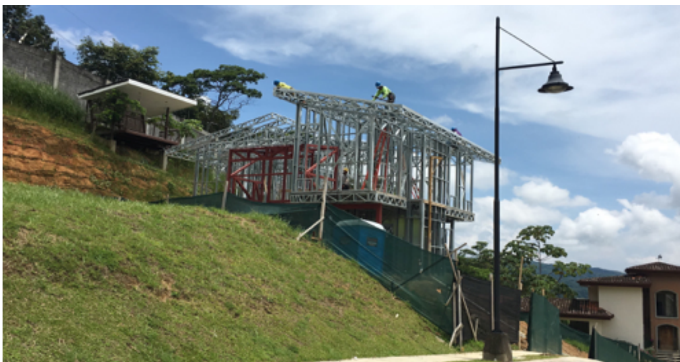
Foto 3. Instalación de la estructura Smart Steel Framing
