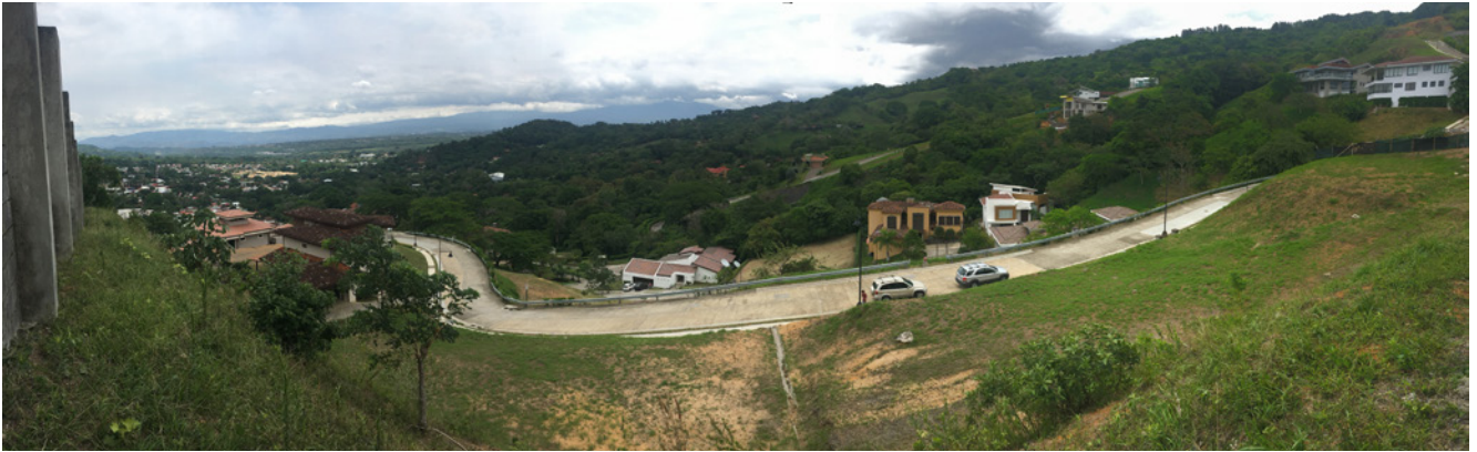
Foto 2. Vista desde la parte superior del talud al sur de la propiedad
