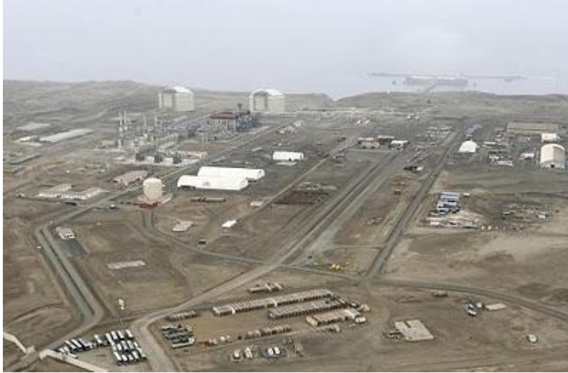
Figura N° 8.5. Vista Panorámica de la Planta de Licuefacción
