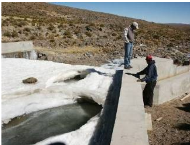
Obra de toma de la microcentral hidroeléctrica
