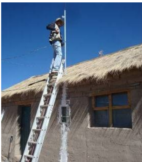
Técnico instalando la acometida eléctrica
