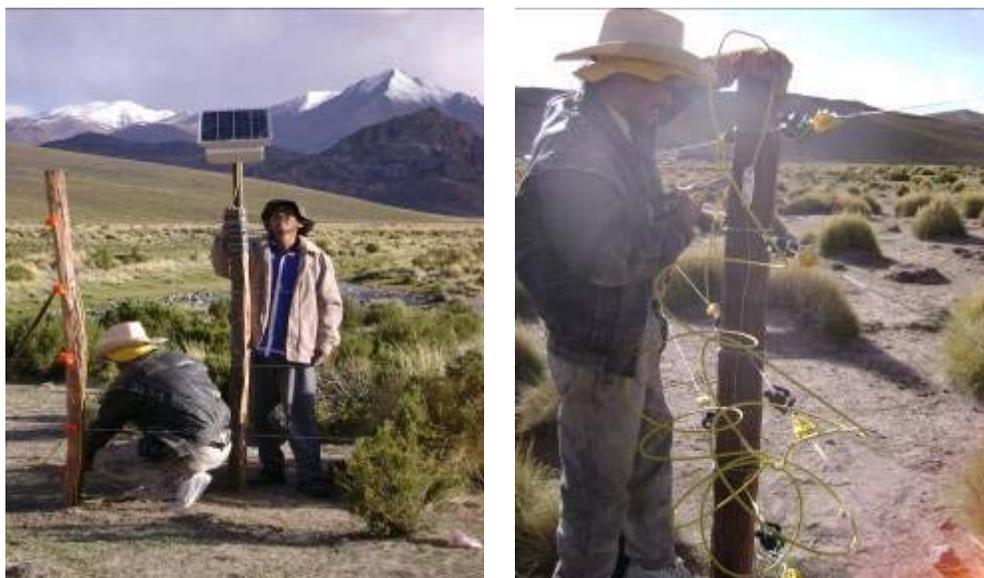
Foto 10. Instalación del electrificador - kit solar y de los pararrayos.
