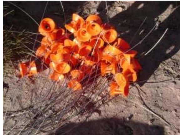
Foto 8. Aisladores turbo de arranque de línea con sus tesadores de acero y aisladores roldana de paso para aislar el alambre electrificado.
