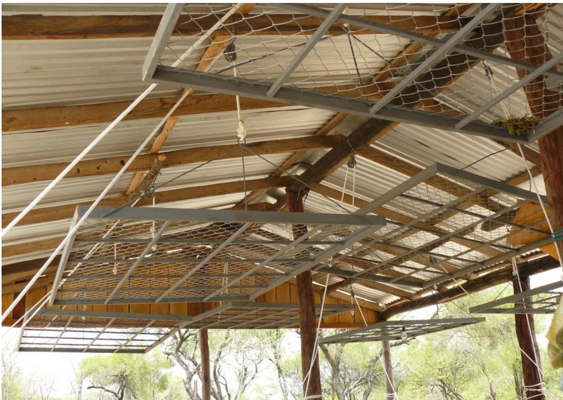
**Ilustración 8:** Bandejas de secado colgadas
