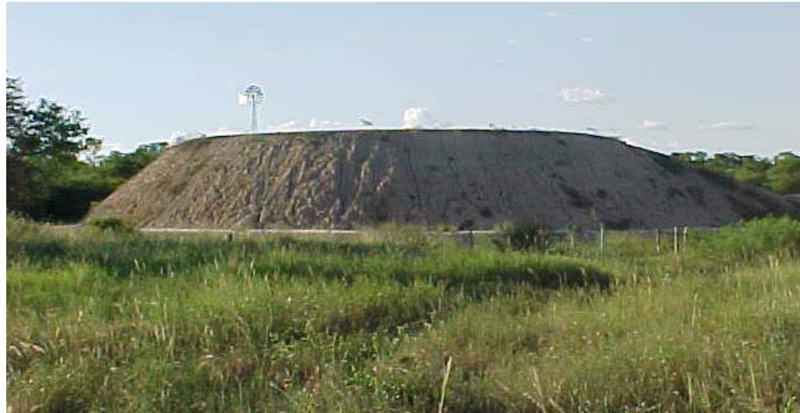
Ilustración 14: Tanque australiano con bomba eólica
