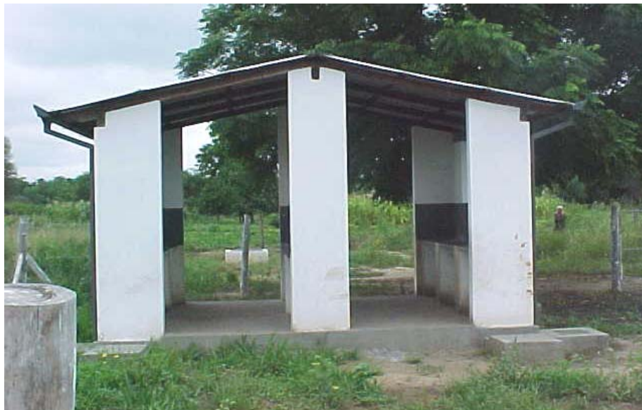
Ilustración 15: Caseta para el lavado de ropa
