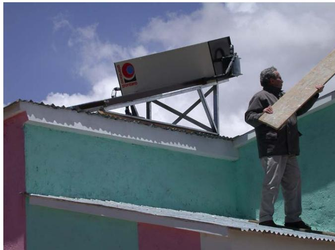
**Foto 3. Instalación típica de sistema termosolar en techo de calamina**
