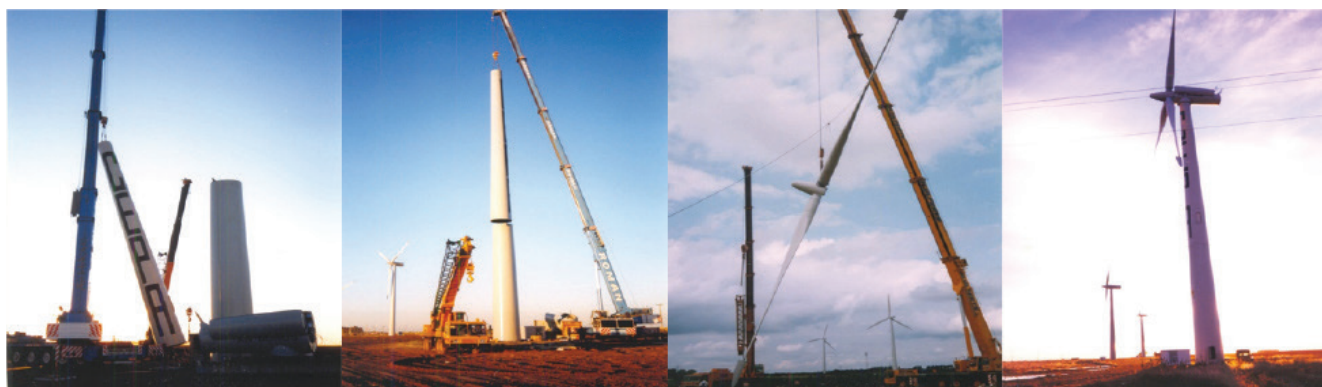
Figura 3. Montaje de los aerogeneradores del parque Centenario. Año 1998.
