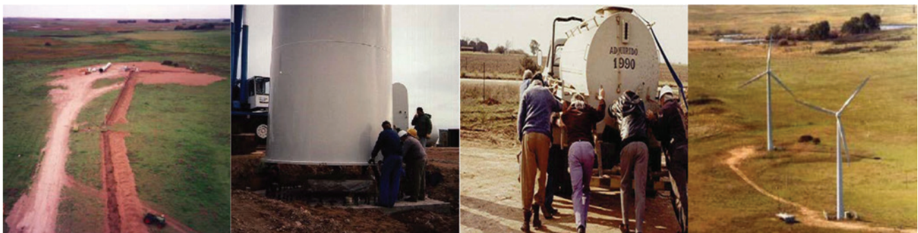
Figura 1. Montaje de los aerogeneradores del parque eólico Mayor Buratovich. Año 1997.
