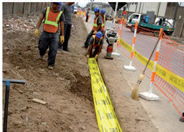
Foto 3 Colocación de la cinta de seguridad
