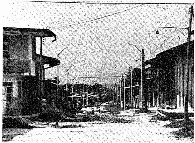
Programa de electrificación Provincial, Distrital y Rural. Casco urbano de Iquitos.
