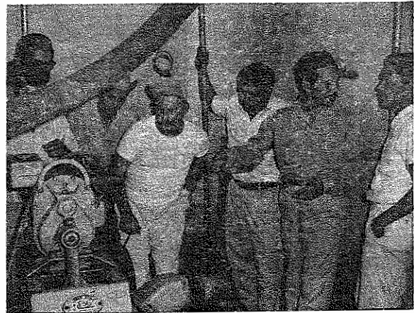
Fig. 15. Interior del cuarto de bombeo y trasiego, en el que se ve una bomba de diafragma REX, con motor de 3.5 H.P., accionado con biogas. Además, allí se encuentran los instrumentos de control y llaves de los sistemas de transporte de líquido, lodos y gases.
