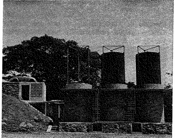
Fig. 4. Planta "El Porvenir" de don Antonio Bonifasi. Con el biogas se acciona un motor Wisconsin de 35 H.P., un molino para 3 toneladas hora, un generador eléctrico de 1 Kwh, una bomba para transporte de lodos y un compresor de gas para llenar botellas con biogas. Ver Cap. II y Cuadro No. 1.
