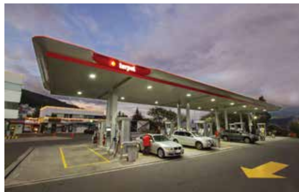
Estación de Servicio Miravalle
