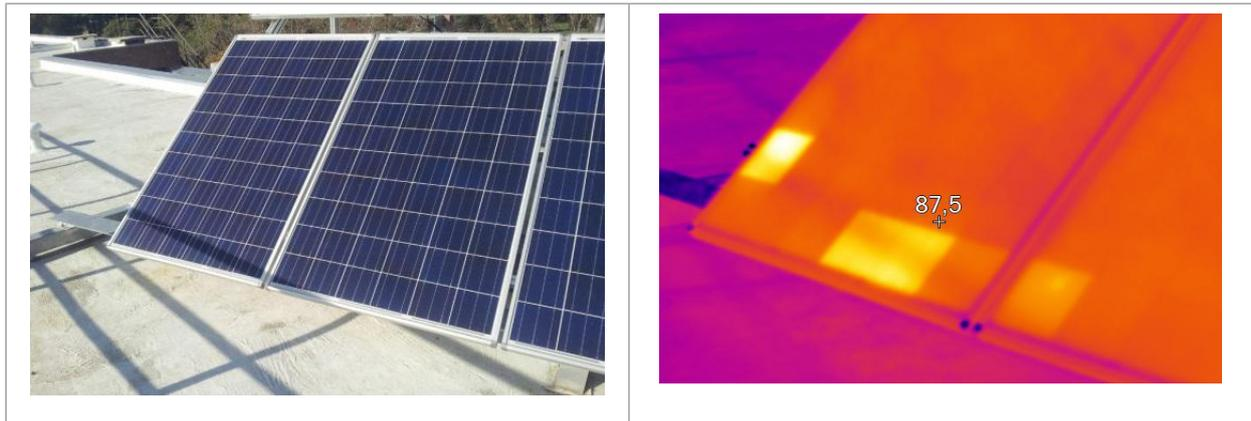
Figura 35. (Izq) Apariencia de panel fotovoltaica al ojo humano con la sombra de un poste circundante. (Der) módulo fotovoltaico de la izq bajo imágenes infrarrojas mostrando las “zonas calientes” que genera la sombra del poste sobre el módulo fotovoltaico. Las celdas afectadas por la sombra están funcionando como cargas resistivas y aumentando su temperatura, hecho que se evidencia mediante el uso de lentes infrarrojas.
