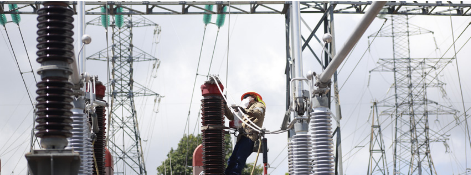
Personal de ETESAL realizando obras de mantenimiento a la red de transmisión
