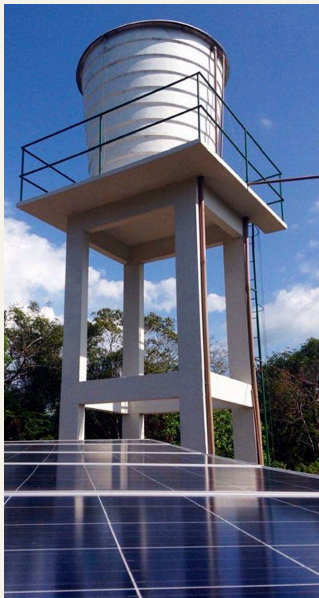
Foto 7 – Bombeamento solar. Local: RESEX Tapajós. Fonte: PSA, 2016
