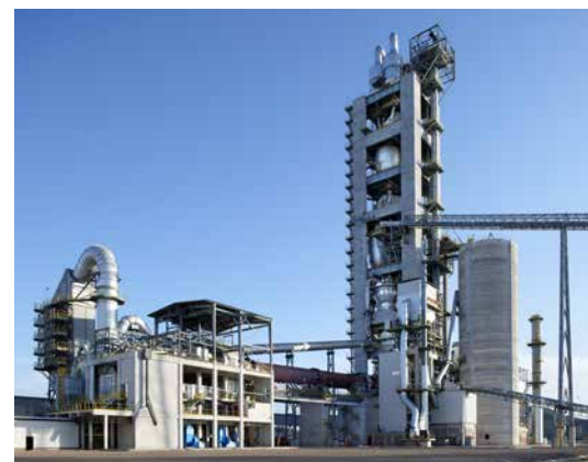
Planta de cemento con función de co-procesamiento (derecha), horno de cemento rotatorio (centro) y clínker de salida (izquierda).
