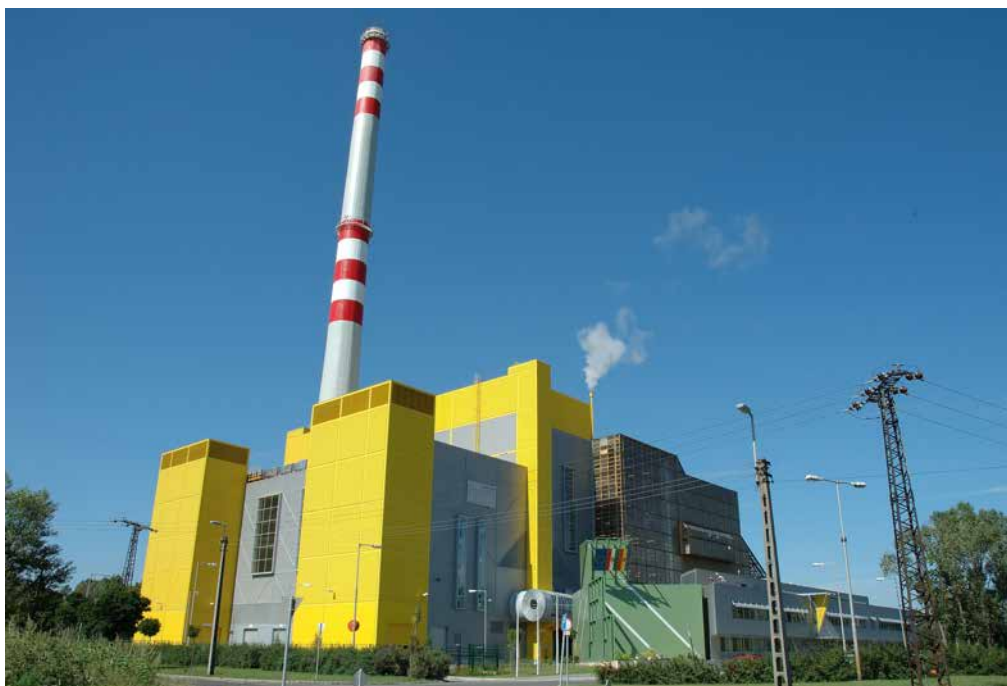
Una planta de incineración de residuos sólidos municipales en Europa.
