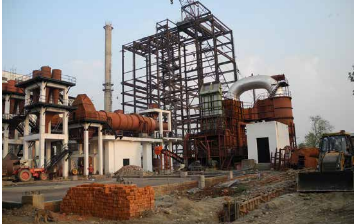
Una planta de cemento en construcción.
