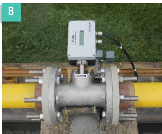
FIGURA 8.14 MEDIDORES DE SALIDA DE BIOGÁS: A) Y B) TIPO VÓRTEX; C) Y D) TIPO MÁSIKO POR DISPERSIÓN TÉRMICA, E) Y F) ULTRASÓNICO.
