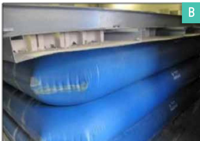
FIGURA 4.9 GASÓMETRO A) DE DOBLE MEMBRANA DE LA PTAR DE SAN PEDRO MÁRTIR, QUERÉTARO; B) DE TUBOS INFLABLES DE LA PTAR INDUSTRIAL CARL MACHER, ALEMANIA; C) Y D) CON MEMBRANA Y LASTRE DE LA PTAR TAUNUSSTEIN, ALEMANIA; E) Y F) DE MEMBRANA EN PTAR DE CASA CUERVO, MÉXICO Y LASTRE CON CILINDRO TELESCÓPICO EN PTAR CCM TECATE, MÉXICO.
