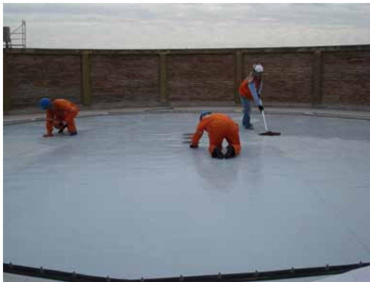
FIGURA 4.15 COLOCACIÓN DE LA MEMBRANA DE FONDO Y BOQUILLAS DE ENTRADA Y SALIDA DE BIOGÁS EN UN GASÓMETRO DE DOBLE MEMBRANA.
