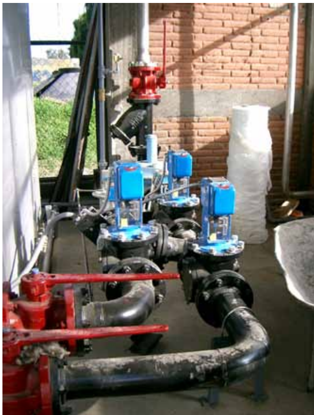
FIGURA 7.3 TREN DE GAS NATURAL Y TREN DE BIOGÁS EN CALDERA CON QUEMADORES DUALES.
