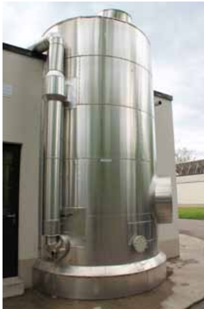
FIGURA 6.5 BIODESULFURACIÓN EN BIOPERCOLADOR - PTAR DE AUGSBURG, ALEMANIA.
