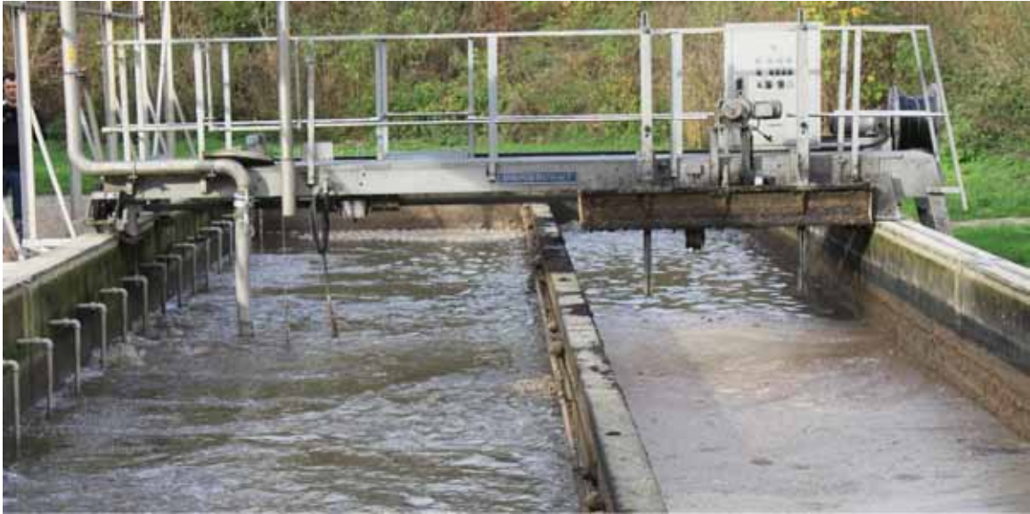
FIGURA 3.7 DESARENADOR AIREADO CON RETIRO SIMULTÁNEO DE GRASA.
