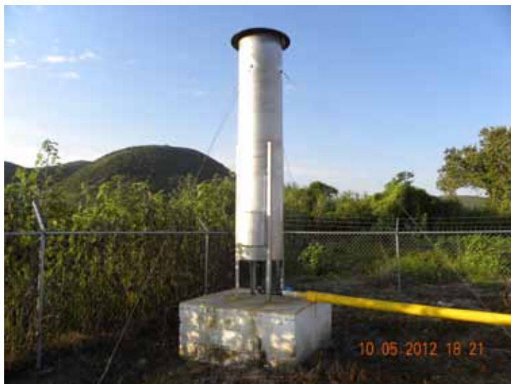
FIGURA 5.8 QUEMADORES DE BAJO COSTO CON DEFICIENCIAS CONSTRUCTIVAS Y DE SEGURIDAD.
