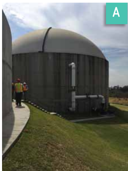
FIGURA 4.22 GASÓMETRO INTEGRADO A DIGESTOR. A) DIGESTOR DE LA PTAR EN ACAPATZINGO, MORELOS, MÉXICO Y B) DIGESTOR EN LA PTAR KETTERING, INGLATERRA.
