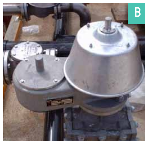
FIGURA 8.6 A) CORTE ESQUEMÁTICO DE UN ARREGLO DE VÁLVULA DE ALIVIO DE PRESIÓN/ROMPEDORA DE VACÍO Y (B) ARREGLO DE VÁLVULA DE ALIVIO DE PRESIÓN/ROMPEDORA DE VACÍO ACOPLADO A ARRESTAFLAMA VERTICAL.
