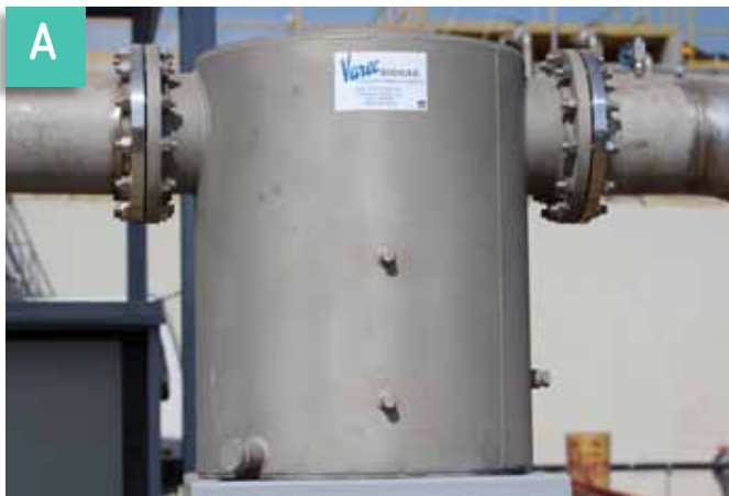
FIGURA 8.5 TRAMPAS A) DE SEDIMENTOS DE 10 GALONES EN ACERO INOXIDABLE (PARA SITIOS DONDE EL GAS ES MUY HÚMEDO) Y B) DE SEDIMENTOS DE 6 GALONES EN ACERO AL CARBÓN RECUBIERTO INTERIORMENTE (PARA SITIOS CON BAJA HUMEDAD).
