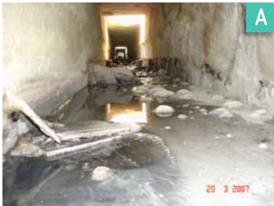
FIGURA 3.19 A) CANALETA DE CEMENTO SIN IMPERMEABILIZACIÓN, DESPUÉS DE CORROSIÓN. B) CANALETA DE CEMENTO RECUPERADA E IMPERMEABILIZADA.
