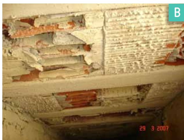
FIGURA 3.19 A) PARED INTERNA DEL REACTOR UASB CON SEÑAL DE CORROSIÓN EN LA INTERFASE LÍQUIDO-AIRE. B) PARTE SUPERIOR DE LA CANALETA DE CEMENTO DEL EFLUENTE TRATADO DEL REACTOR UASB COMPROMETIDA POR LA CORROSIÓN.
