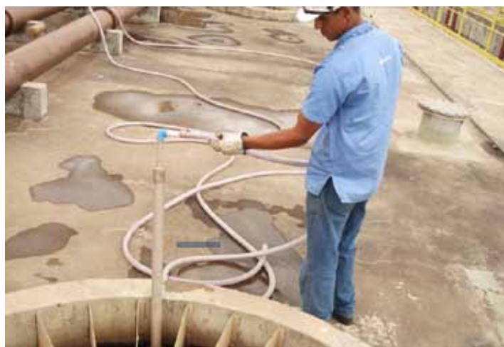
FIGURA 3.22 PROCEDIMIENTO MANUAL DE ELIMINACIÓN DE OBSTRUCCIÓN DE LAS TUBERÍAS DE ENTRADA DE AGUAS RESIDUALES SANITARIAS DE UN REACTOR UASB.
