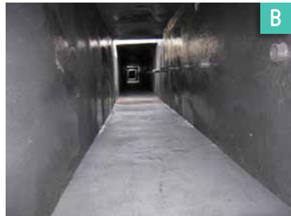
FIGURA 3.19 A) CANALETA DE CEMENTO SIN IMPERMEABILIZACIÓN, DESPUÉS DE CORROSIÓN. B) CANALETA DE CEMENTO RECUPERADA E IMPERMEABILIZADA.
