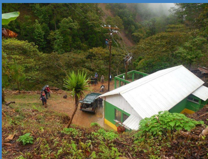
Vista aérea de la casa de maquinas de la micro central hidroeléctrica Batzchocola.
