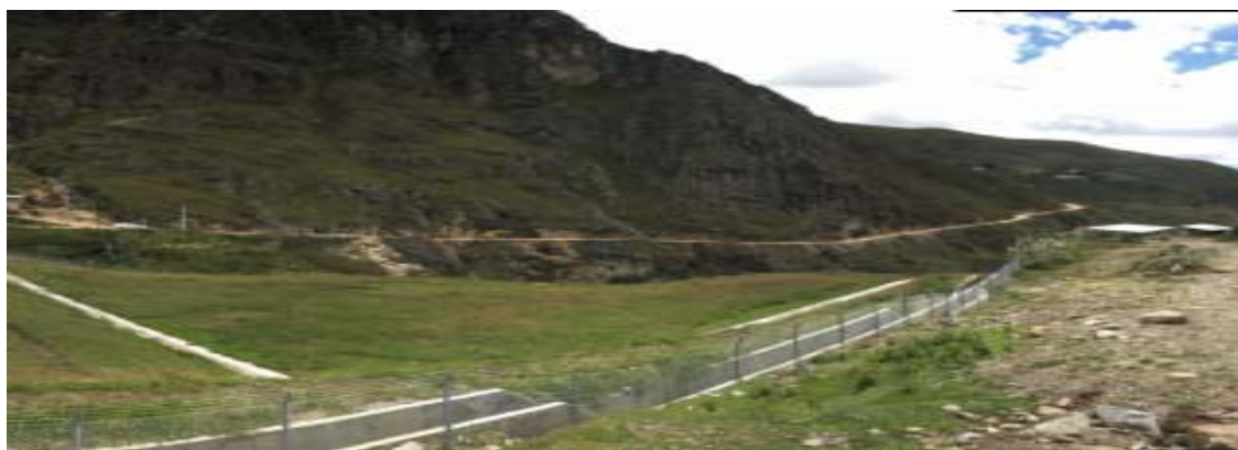
Proyecto de remediación Dorado-Barragán, Planta de Procesamiento
