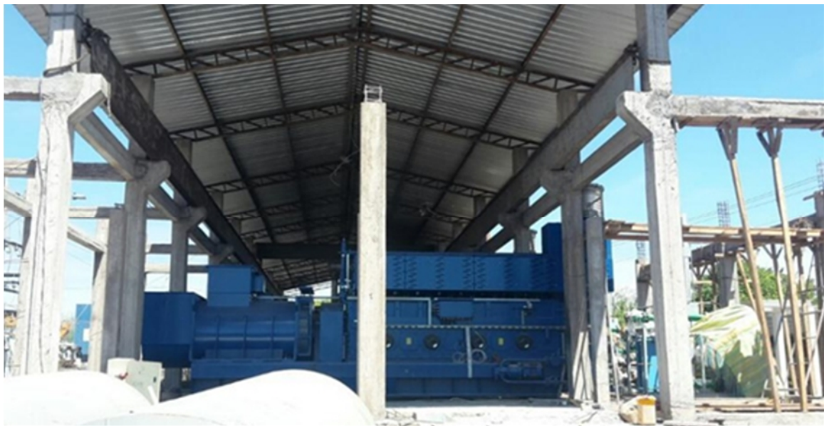
Figura 7: Instalación de nuevos generadores a diésel en la central térmica
