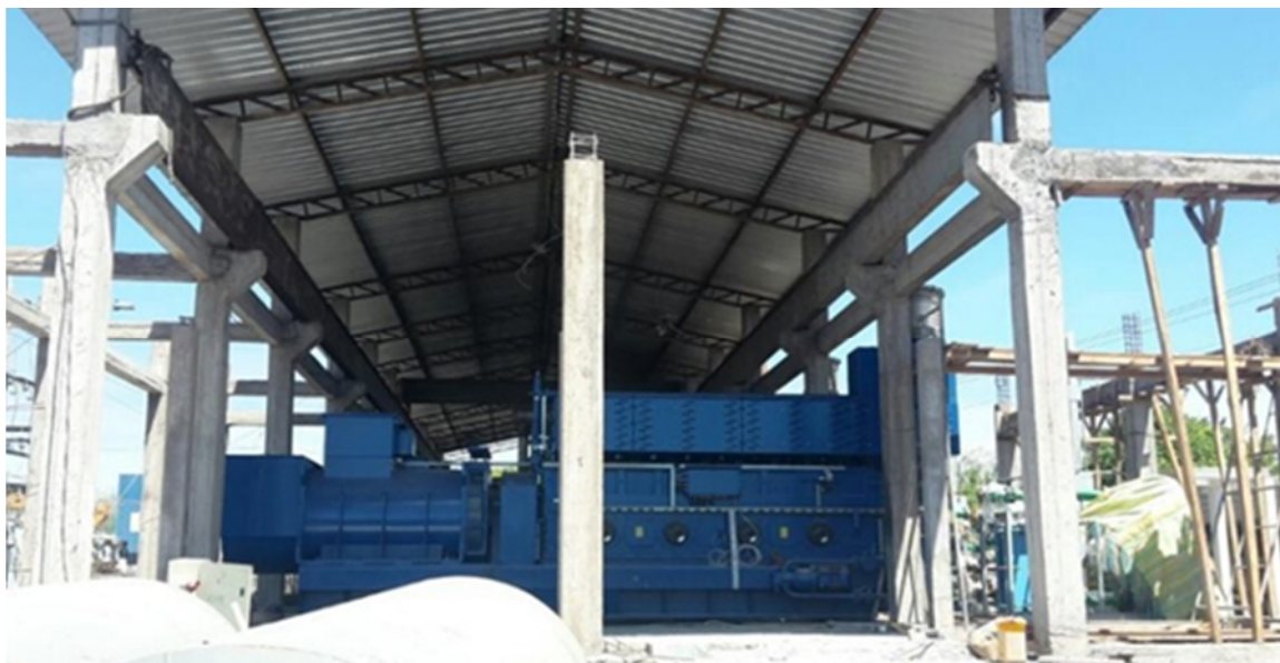
Figura 2: Instalación de 2 nuevos generadores a diésel en la central térmica
