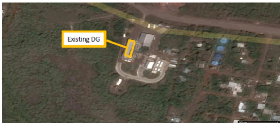
Figura 2: Central a diésel existente en la Isla San Cristóbal
