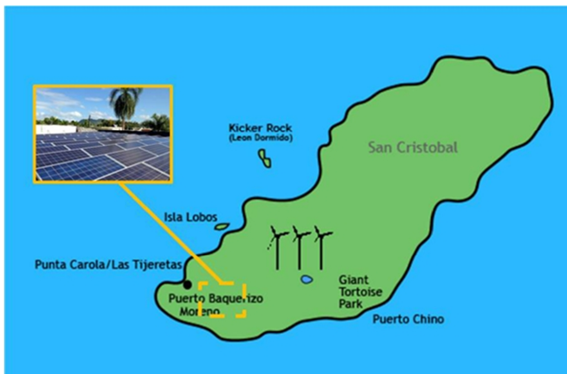
Figura 1: Red híbrida eólico-fotovoltaica en San Cristóbal (a 2016)
