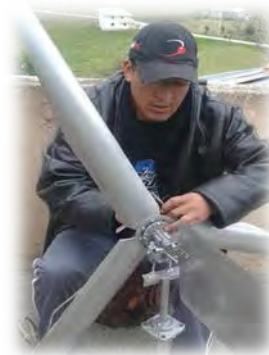
Figura 4. Armado del aerogenerador.
