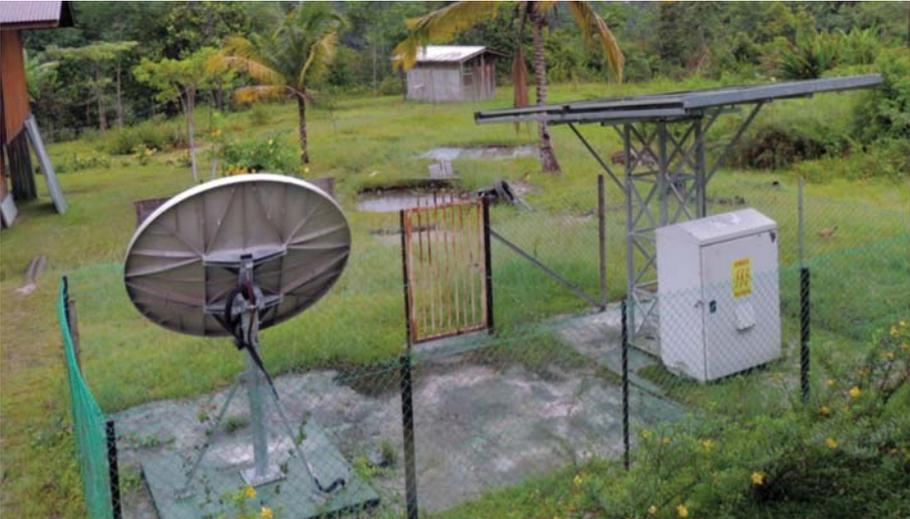
**Un sistema de micro-red en la aldea de Sabah, Borneo Malayo. El sistema sirve a una comunidad de 200 y proporciona servicios de energía para el hogar, telecomunicaciones y satélite (en la foto), el bombeo de agua para estanques (en el centro) y refrigeración. El suministro incluye generación hidroeléctrica de baja potencia y solar – aquí aparece un panel pequeño y hay otros distribuidos sobre los techos de edificios.**
