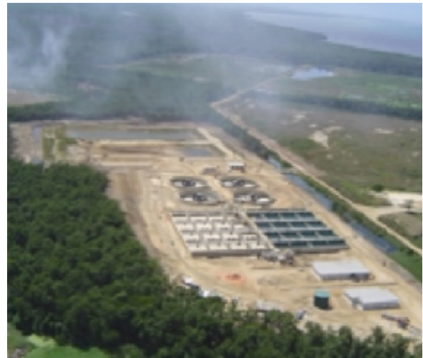
Figura 3.4. La Planta de Tratamiento de Aguas Residuales de Beetham in Puerto España es objeto de este caso de estudio
