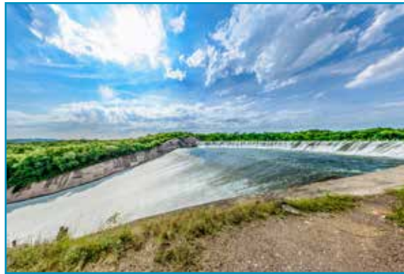
Planta hidroeléctrica de Sanalona, Sinaloa.
