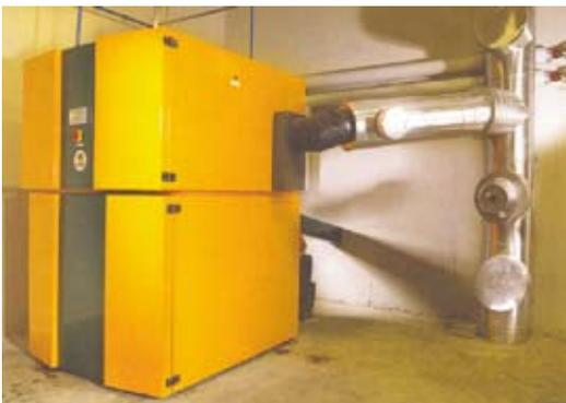
El uso de combustible sólido en calderas de pellets, ha evolucionado hasta tal punto que su producción de calor es tan eficiente como la obtenida del gas. Los pellets son introducidos automáticamente y las calderas pueden funcionar durante docenas de días, las horas de productividad se pueden fijar y su capacidad puede ser debidamente regulada.
