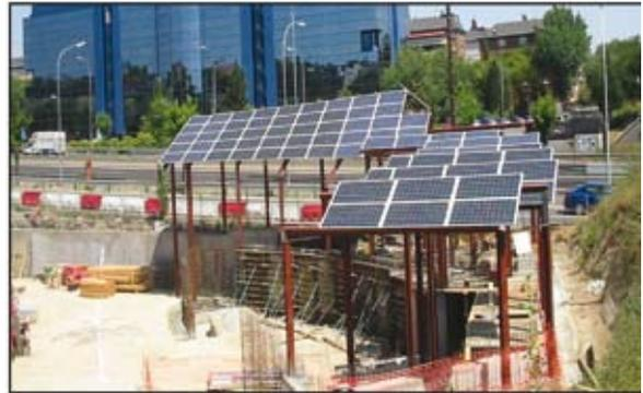
En la fase de diseño, se propuso una estructura en forma de U con mayor capacidad para módulos (192) rodeando a las viviendas, sin embargo, debido a la proximidad de las viviendas, sombreados y problemas de espacio se ha tenido que reducir hasta 84 módulos para evitar sombra sobre ellos.
