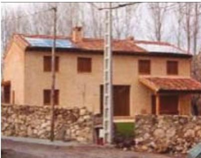
Una instalación fotovoltaica de 4 kWp genera anualmente 4.800 kWh/año, evitando la emisión de 1,8t CO<sub>2</sub> a la atmósfera. Este es un ejemplo de cómo cualquier particular puede convertirse en generador de energía eléctrica y contribuir al cuidado del medioambiente.
