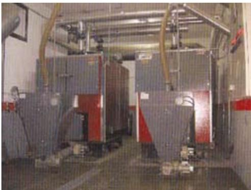
Esta instalación provee de calefacción central a 160 viviendas de 100 m<sup>2</sup>. El uso de biomasa como combustible para producción térmica doméstica, supone el uso de una energía renovable, no contaminante y 100% autosuficiente, es decir, no precisa de ningún otro combustible convencional fósil de apoyo.
