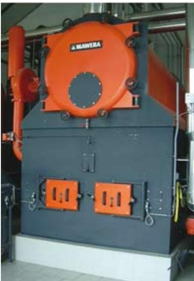
Las plantas tipo *district heating* (redes de calefacción) presentan una potencia instalada superior a 500 kW, siendo los valores normales entre 600 y 2.500 kW. Estos sistemas se utilizan para dar calefacción y agua caliente sanitaria a varios edificios y viviendas unifamiliares, a un barrio o a poblaciones.
