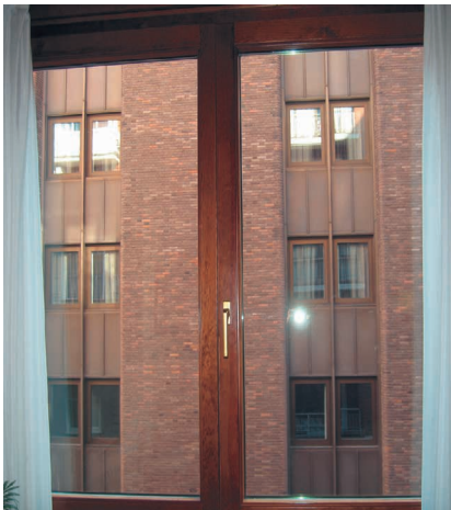
Foto 2.3. Ventana de altas prestaciones energéticas con reducidos valores de U y g, y alta transmisión luminosa con acristalamiento:
