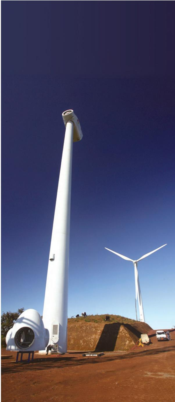
Buje listo para ser levantado en el aerogenerador No. 2
