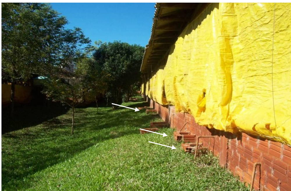
Figura 4 – Cañería colectora de deyecciones
