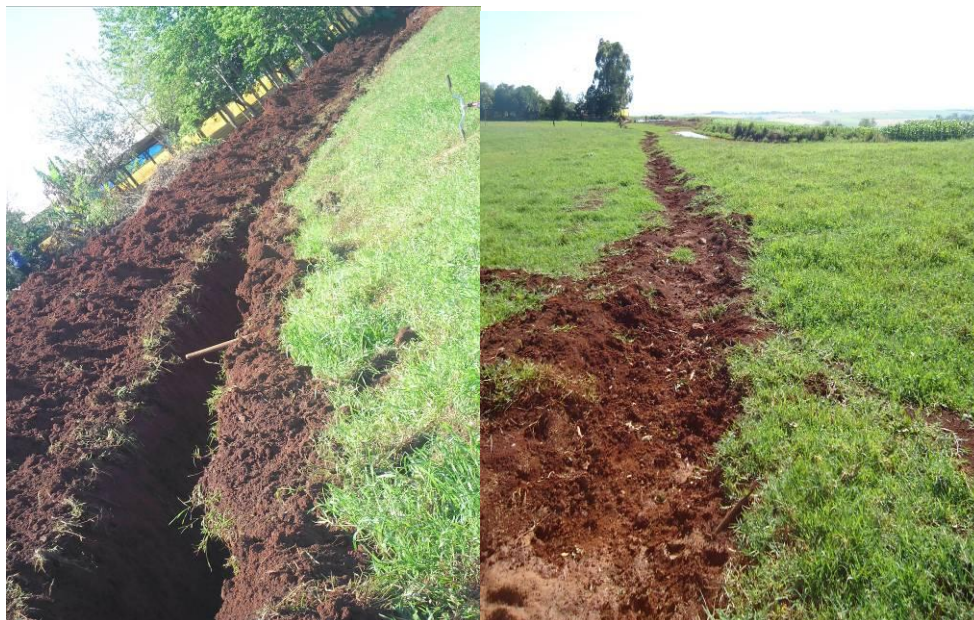
Figura 12 – A la izquierda, el gasoducto en construcción; a la derecha, el gasoducto terminado
