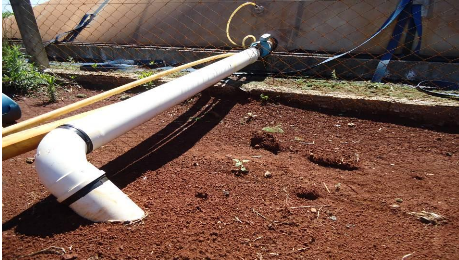
Figura 13 – Inicio del gasoducto (propiedad “B”)
