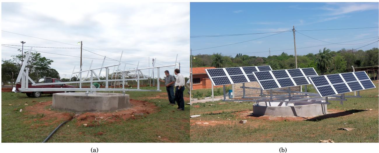
**Figura 15:** Estructura de dos grados de libertad. (a) Proceso de montaje. (b) Vista general del montaje concluido.
