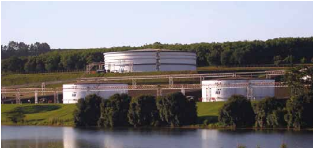
A Usina São Martinho processa o vinhoto e usa o biogás para produção de energia.
