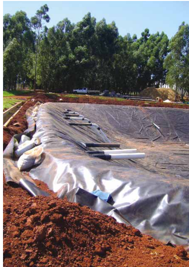
Biodigestor em construção.
