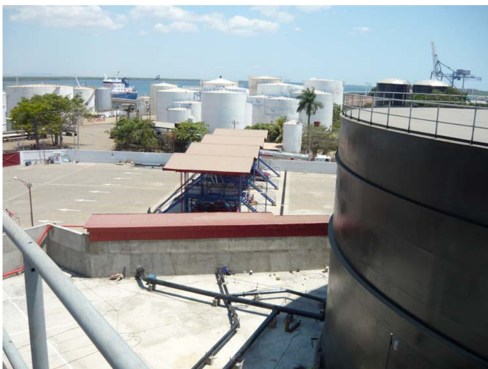
Tanques de Almacenamiento “Benjamín Zeledón – Corinto”
